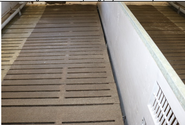
Billede 3. Sti med betonsplategulv og drænet gulv behandlet med Titaniumdioxid, Ikadan-inventar til bund af gyllekumme, plastkrybbe
