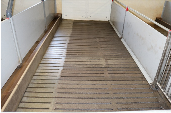
Billede 1. Sti med traditionelt betongulv, overfladebehandlet med en eller to gange vandglas, AcoFunki-inventar med hulkelliste og nedstøbte stolper og polyesterbetonkrybbe
