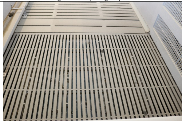
Billede 4. Sti med støbejernsgulv i gødeområdet, betonsplategulv og drænet gulv, Ikadan-inventar med hulkelslister og uden stolper og fodplader, plastkrybbe
