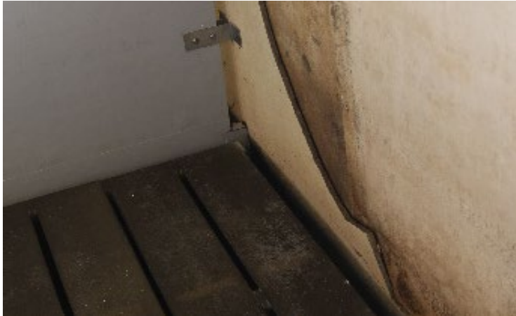
Figur 14. 4-5 cm sprække mellem gulv og inventar og mellem inventardele
