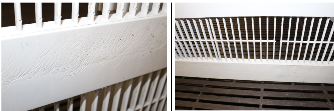
Stiadskillelse med mærker efter grisenes undertænder
