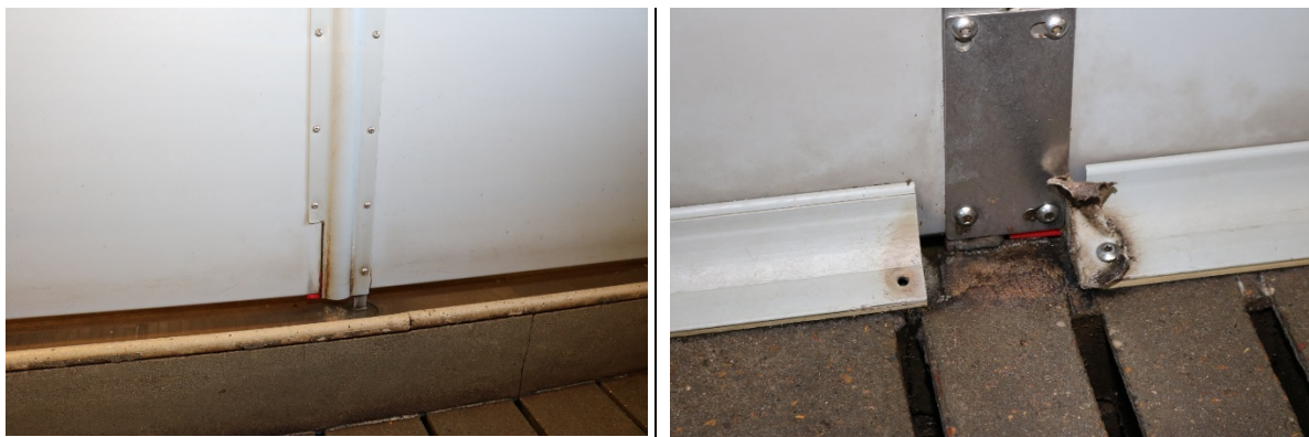
Figur 16. Eksempler på inventarløsninger med utilfredsstillende holdbarhed
