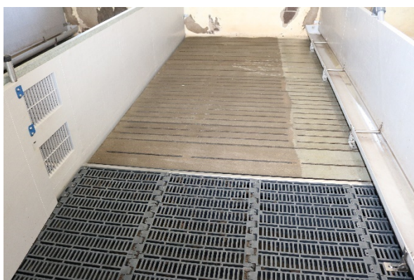
Billede 1. Sti med løftbart plastspaltegulv i gødearealet, stitype 2.7
